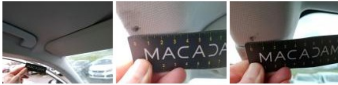
Garnit. montant AVG, Brûlé, Smart repair
