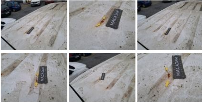
Jante de secours, Manque, E - Remplacer
